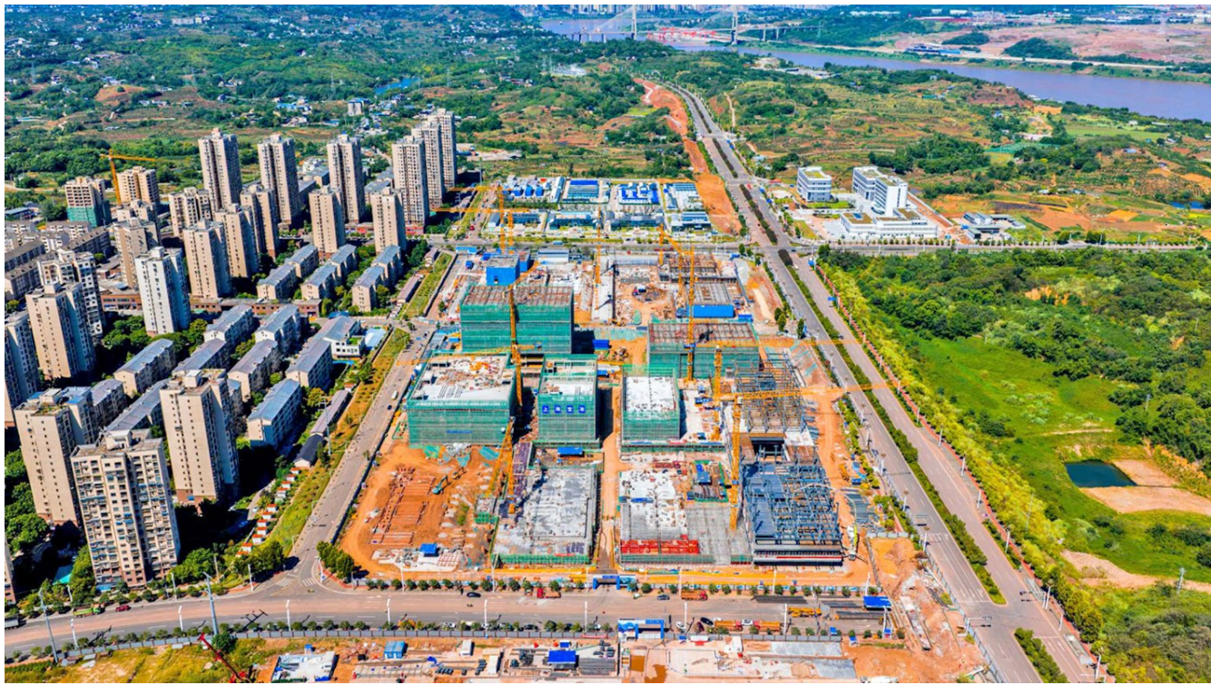
先进机电装备和物流产业园建设现场。 江津报记者 刘星欣 摄
