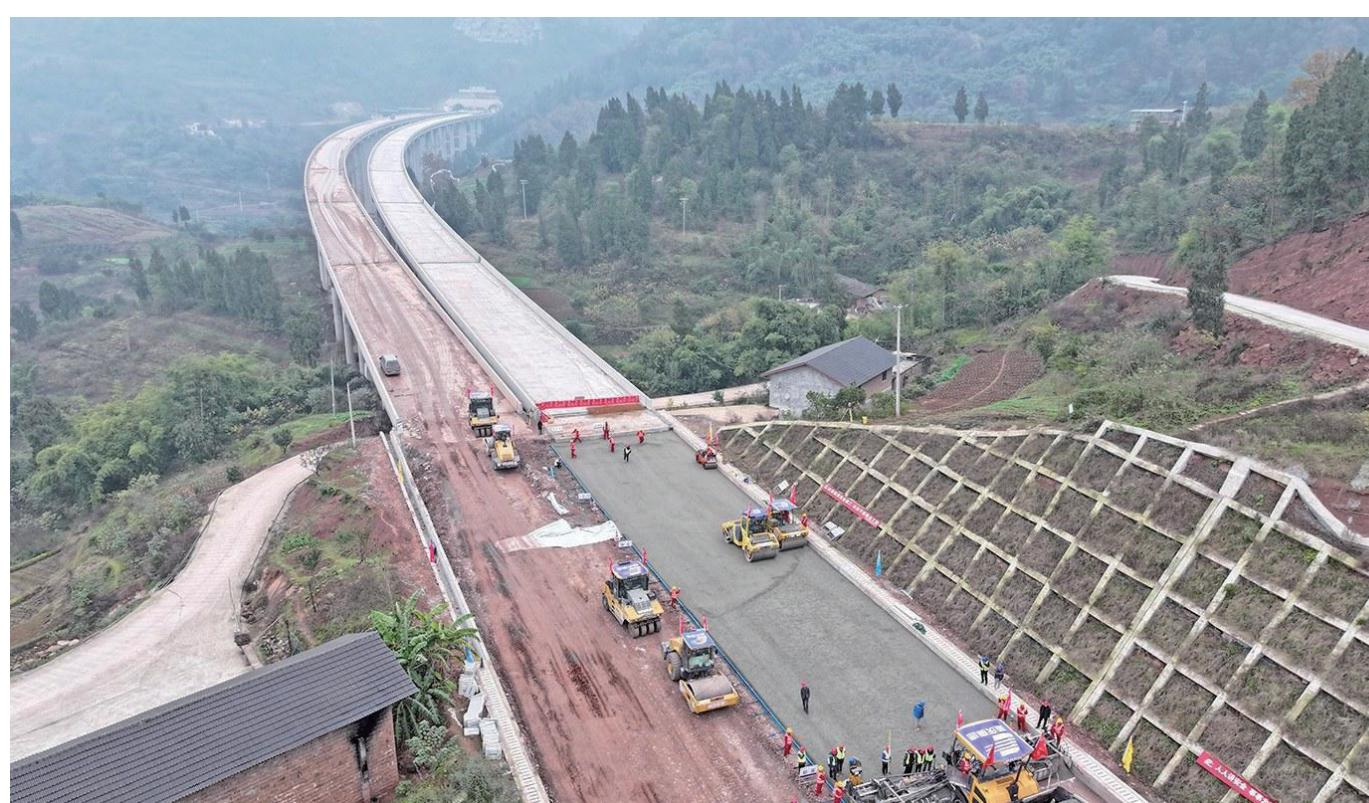
江津报讯(记者 苏盛宇)2025年12月29日,冬日的江津区嘉平镇寒意正浓,但渝赤叙高速公路施工现场却热气腾腾——首段水稳层试验段摊铺工作正式拉开帷幕,摊铺机、压路机协同作业,在山间勾勒出交通大动脉的雏形。这标志着这条串联黔川渝三省市的重要通道,向路面工程全面推进迈出了关键性一步。
